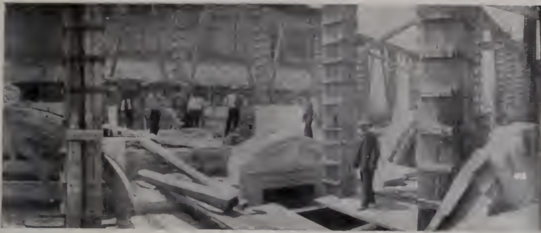
298. — I lavori dello stilobate procedono felicemente
